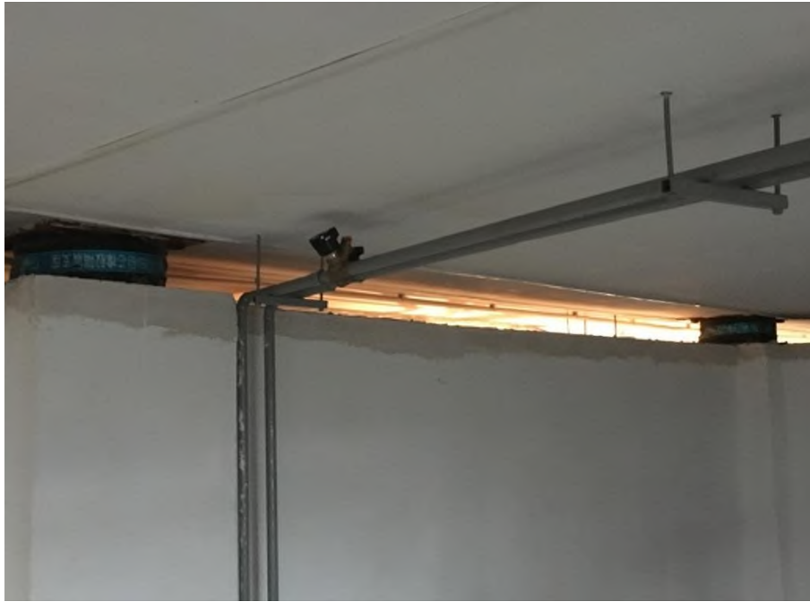
Рисунок 2 – Общий вид установленных резинометаллических опор
