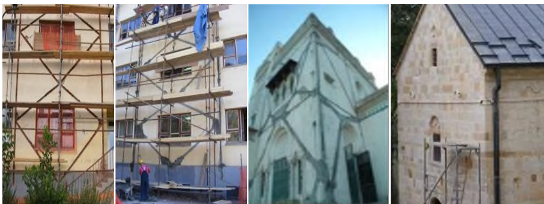
Фото 6. Примеры монтажа элементов Системы ДЦ 90.
