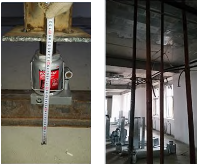
Рисунок 4- Общий вид домкрата со стойкой и временных опор
