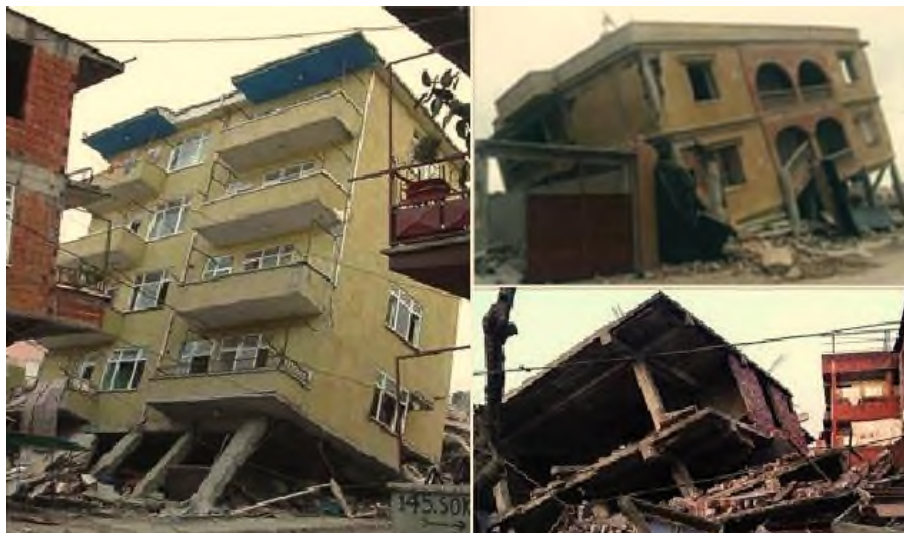
Рис. 3. Разрушение ЖБКНИ зданий
